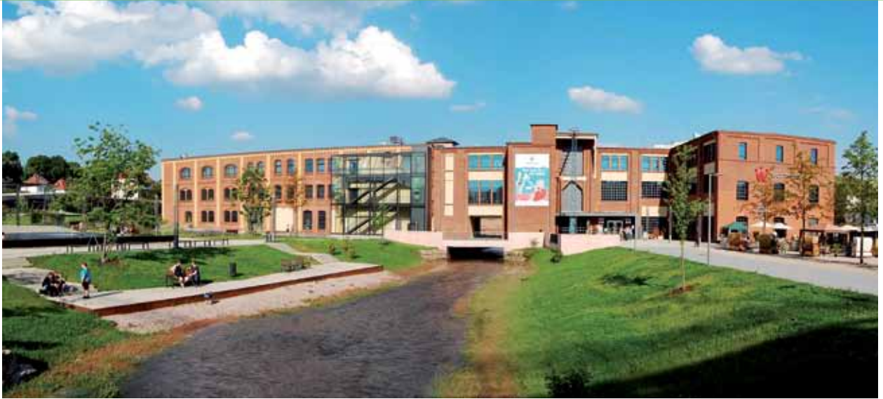
Die Geis durchfließt den Park nun als offener Wasserlauf.
