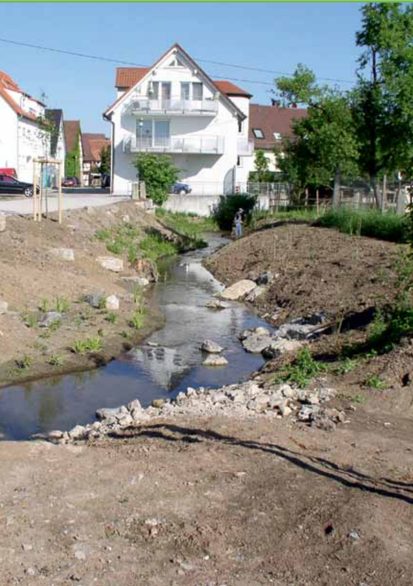
Die Fließgeschwindigkeit der Lauter in Kirchheim wurde durch die Umgestaltung deutlich reduziert.
