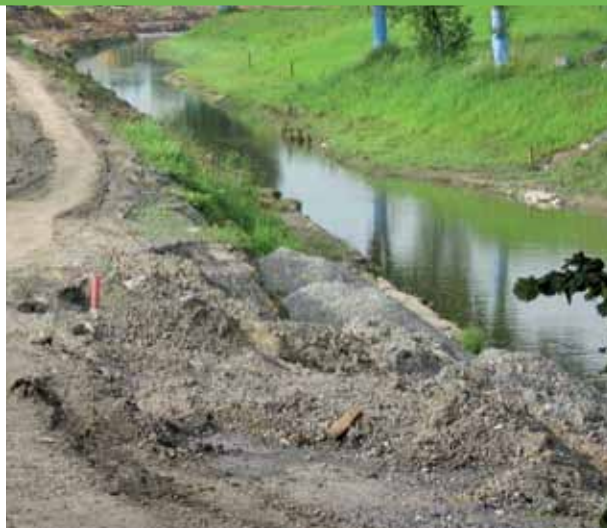
Emscher-Umbau: Nebenlauf Körnebach
