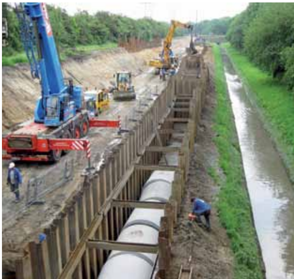
Neue Rohre für das Schmutzwasser
